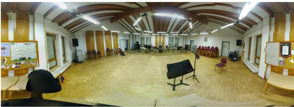
**Abbildung 5:** Probenraum für Bläserorchester mit Akustikelemente im Eigenbau: Holzpyramiden als Diffusor und gelochte Gipsfaserplatten als Absorber.
